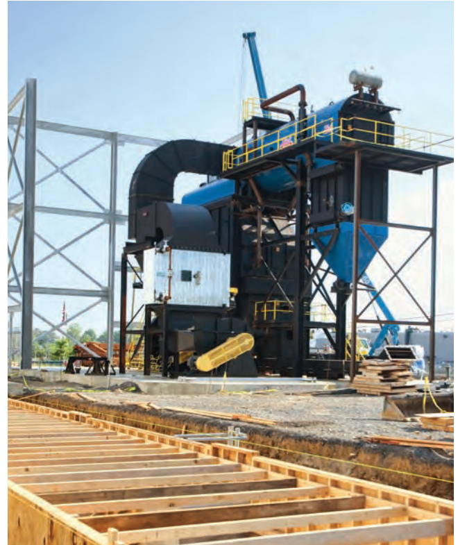
Re2E construction site
